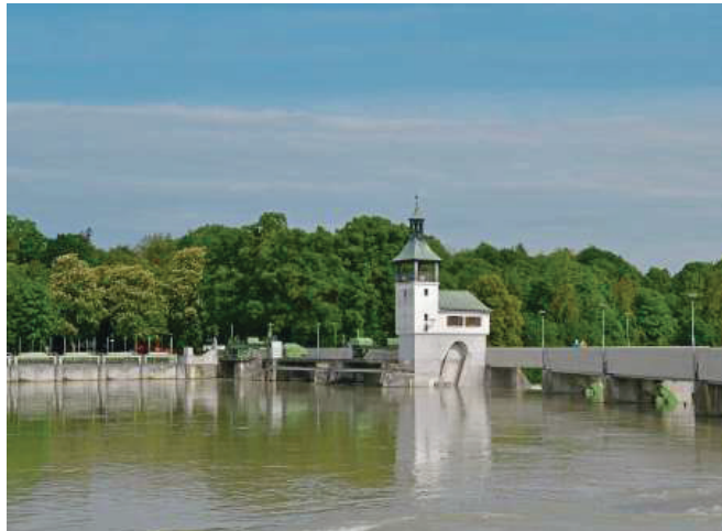
Ursprung der meisten Augsburger Kanäle: das Lech-Stauwehr am Hochablass, seit über 750 Jahren wesentlicher Bestandteil der Augsburger Wassernutzung. Der heutige Zustand stammt aus dem 1912. Fotos: Ulrich Traub
