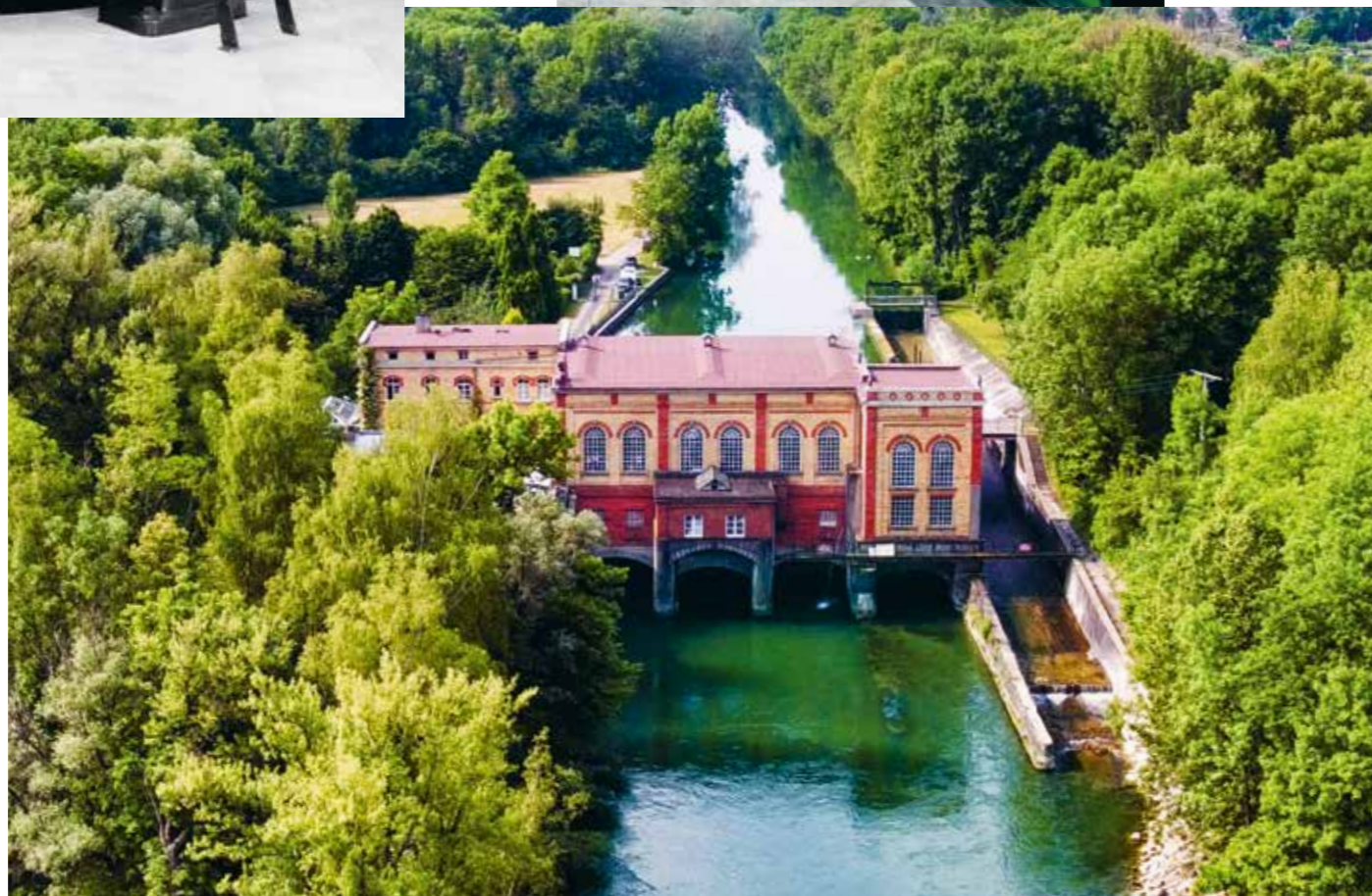
Kraftwerk an der Wolfzahnau
