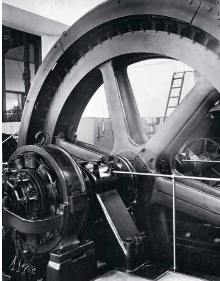
Schwunradgenerator im Kraftwerk an der Wolfzahnau
