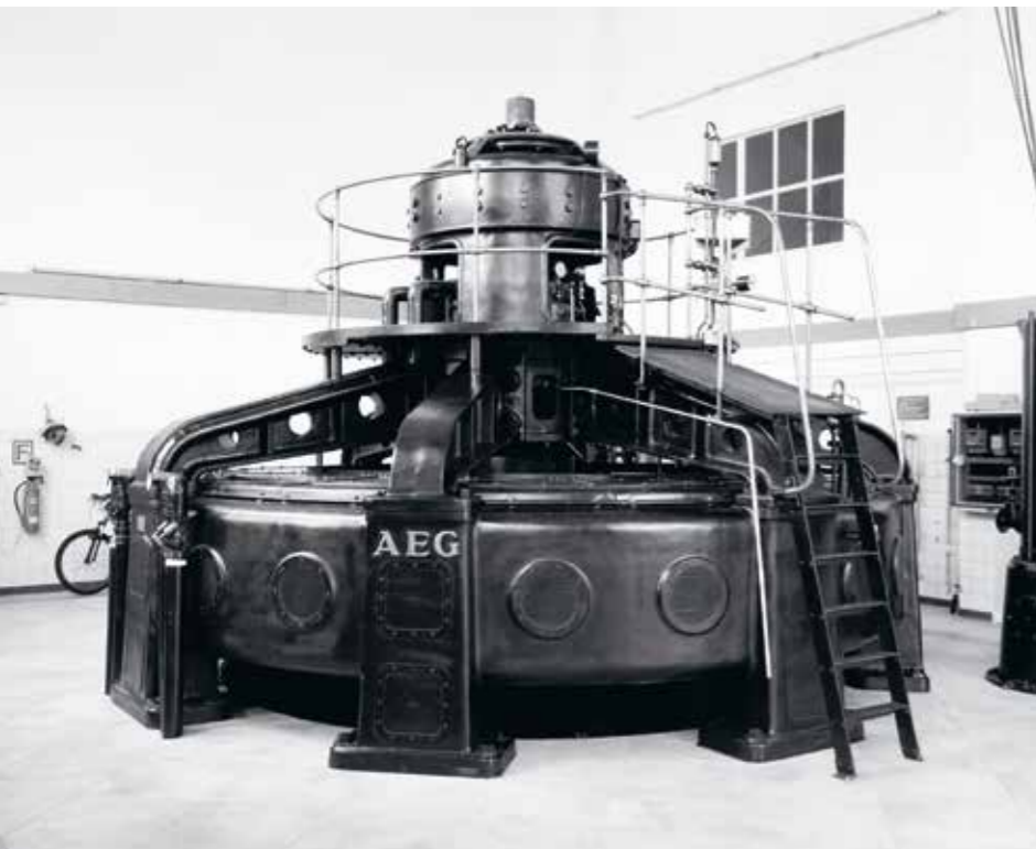
AEG Bell Generator von 1922, Kraftwerk am Proviantbach
