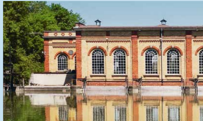
Kraftwerk an der Wolfzahnau
